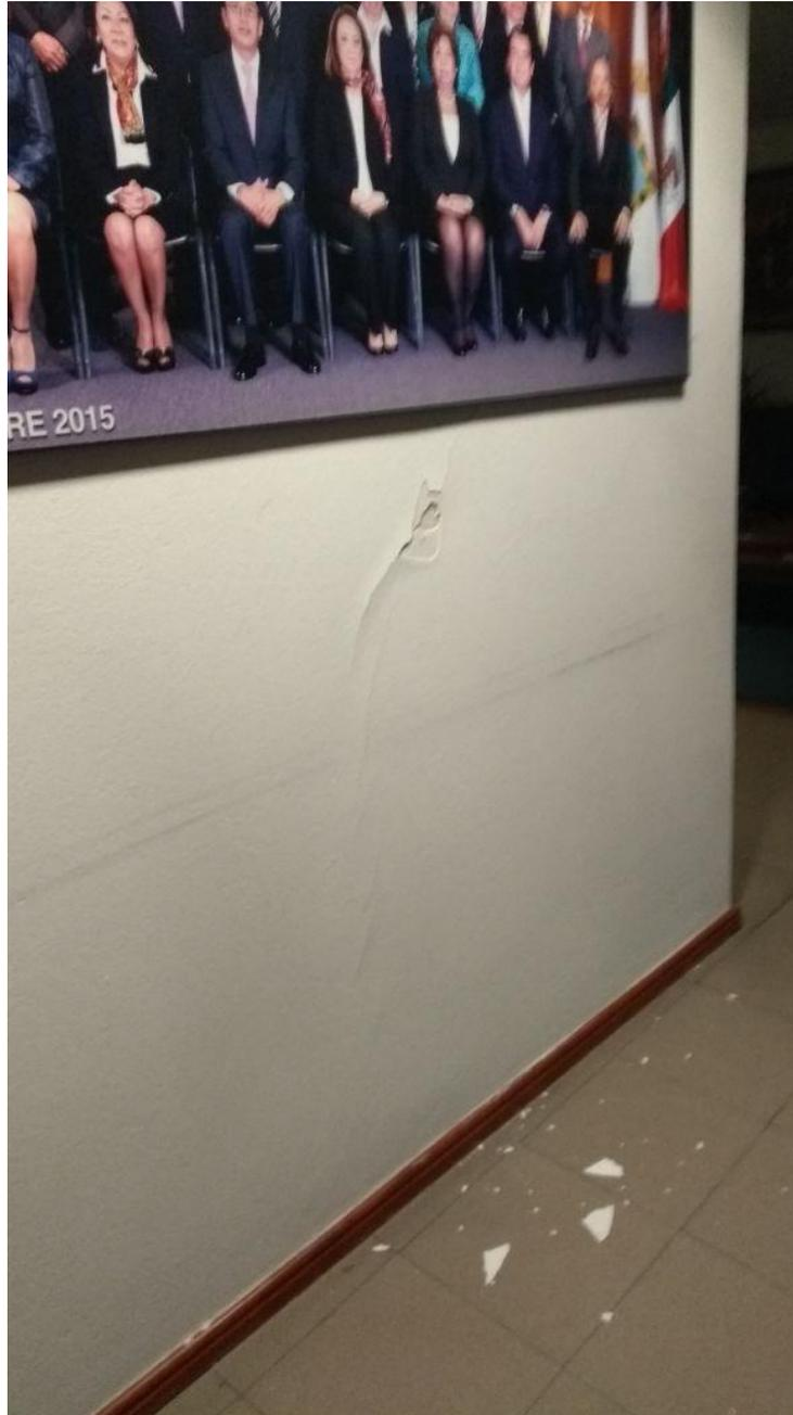
**10.- DESPRENDIMIENTO DE PINTURA Y FISURA MUY DELGADA EN MURO DIVISORIO**
