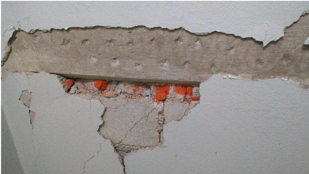
**9.- DESPRENDIMIENTO DE ACABADO Y FISURA EN SUPERIOR DEL MURO NO ESTRUCTURAL**
