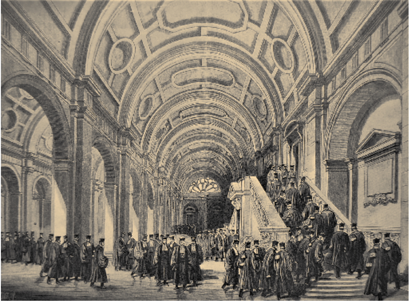
El nuevo vestíbulo público del Palacio de Justicia, A. Deroy
